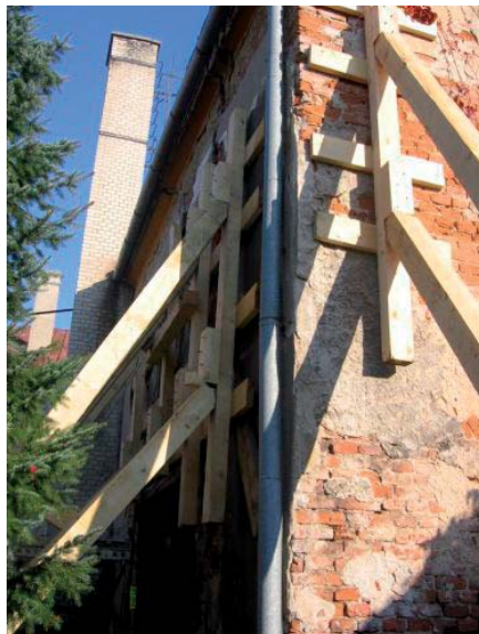
Statické zajištění budovy dvorního traktu hotelu U Tří králů
