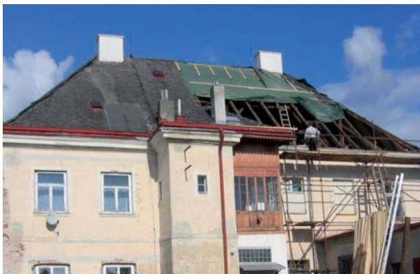
Oprava krovů a střechy budovy fary v Tovačově
