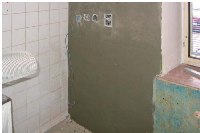
Izolace stěn proti zemi vlhkosti v prostorách lékárny
