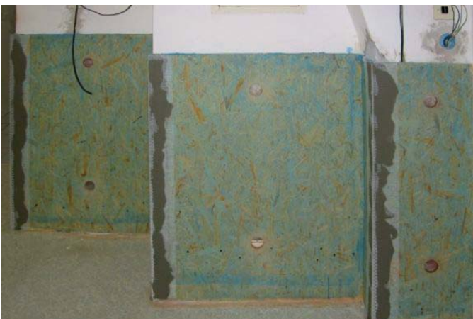
Izolace stěn proti zemi vlhkosti v prostorách lékárny
