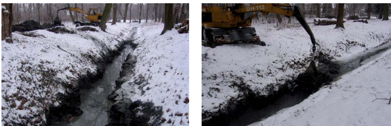
Opravy hrází malých vodních toků
