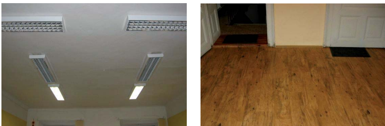
Výměna stropních svítidel a podlahové krytiny v ZUŠ Tovačov
