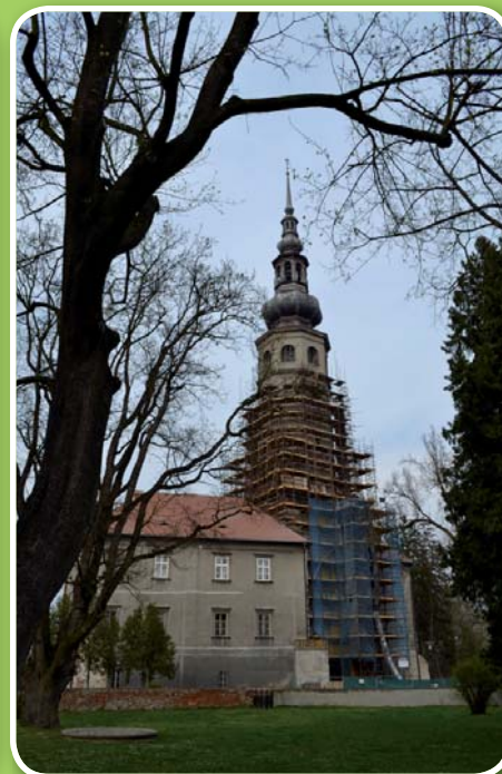
pohled na věž od západu
